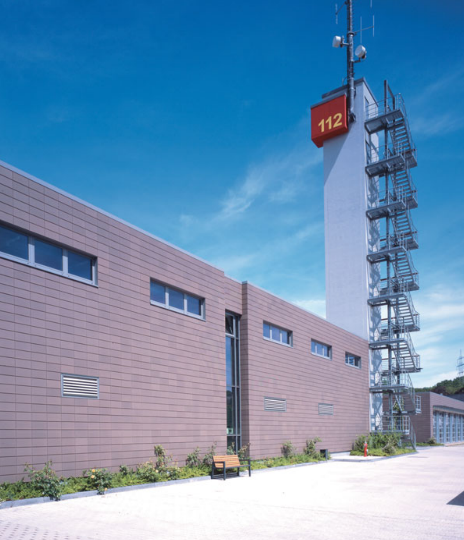
Пожарно-спасательная часть г. Хаген-Хоенлибург Архитекторы: Kamel Architekten und Ingenieure, г. Хаген Цвет: кварцево-серый Поверхность: стандартная
