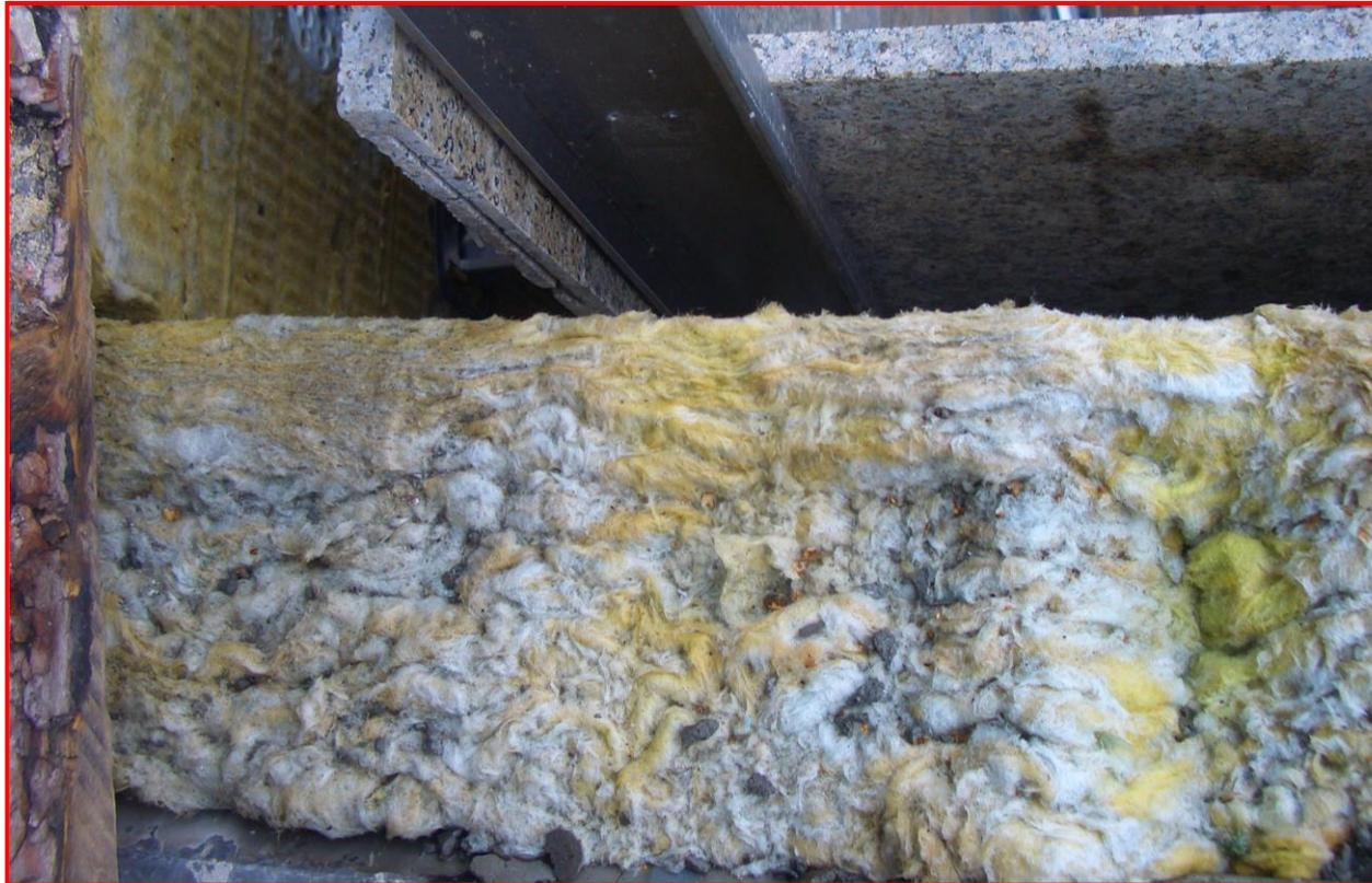
*В зимнее время инфильтрация вызывает **дополнительные теплопотери**, а эксфильтрация способствует конденсации влаги в минераловатном утеплителе, при этом происходит **разрушение утеплителя**, что приводит к значительному увеличению затрат на отопление и **система перестает быть защитой для несущих стен здания**.*
