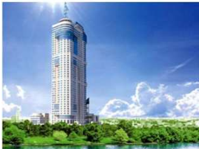
Жилой комплекс "Континенталь" Высота 167 метров
